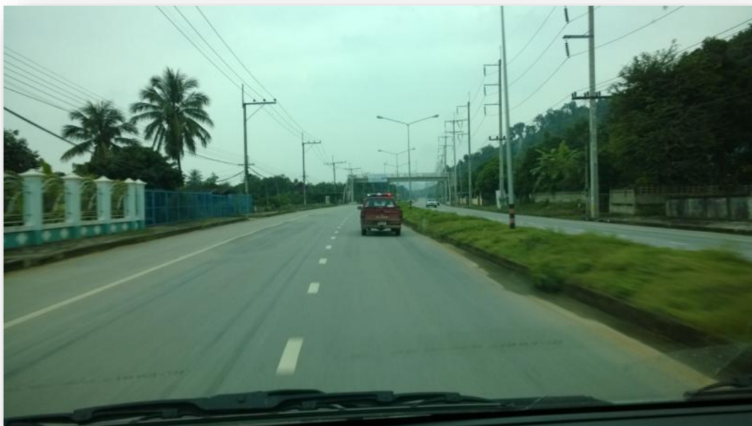
ภาพที่ 16 สภาพถนนหลวงสายเชียงของ-เทิง ช่วงบุญเรือง-สะพานข้ามแม่น้ำโขง เป็นถนน 4 เลน สร้างเสร็จสมบูรณ์แล้ว ในขณะที่ช่วงบุญเรือง-พญาเม็งราย อยู่ระหว่างก่อสร้าง คาดว่าจะแล้วเสร็จสมบูรณ์ภายในปี 2558
